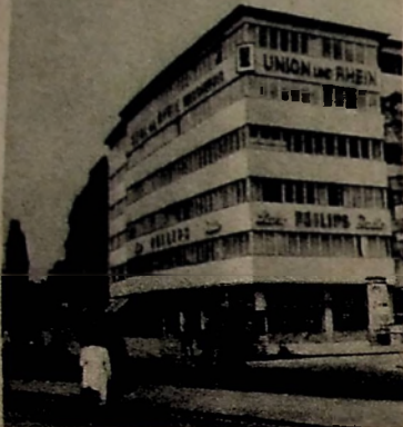
Das Berliner Philips-Filialbüro ist in der Tauentzienstraße 1 untergebracht
