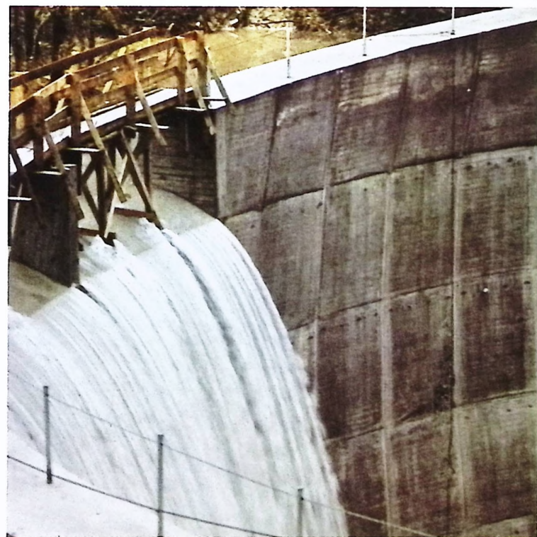
2 u. 3 Ofenwaldsperre bei Füßen mit Zielmarken zur ständigen Über- wachung der Staumauer
